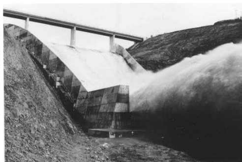
(الف) نمایی از سرریز جامی و جت آزاد جریان
