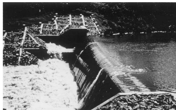
الف) نمایی از پرش هیدرولیکی و تغییر عمق سیال
