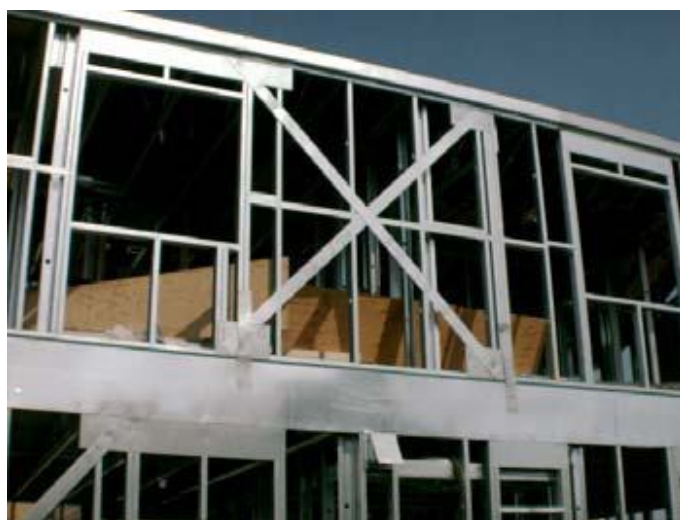
شکل ۲-۳ - اسکلت سازه فولادی سرد نورد شده LSF دارای مهاربند نواری [۶]
