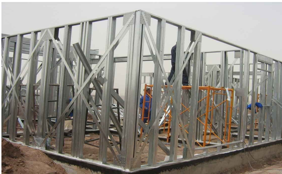
شکل ۱-۱: نمونه‌ای از سازه‌های دیواری LSF دارای مهاربندهای نواری [۲]
