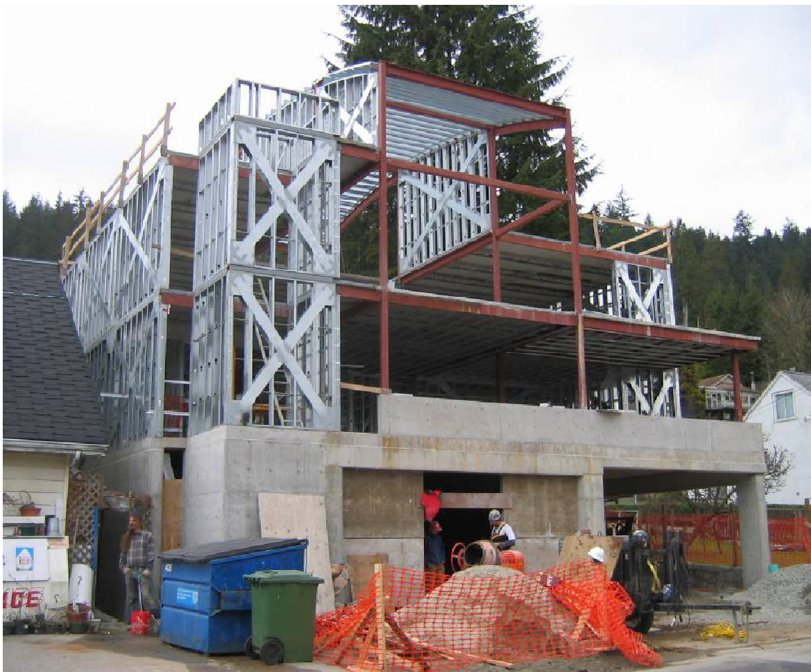
شکل ۳-۱: نمونه‌ای از ترکیب قاب LSF با تیرها و ستونهای فولادی گرم نورد شده [۴]
