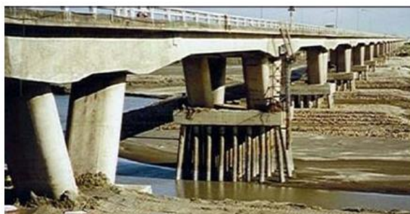
شکل (۱-۲): پل ساخته شده با پایه‌های کج در صفحه عمود بر جریان در کشور تایوان (Melville & Coleman, 2000)
