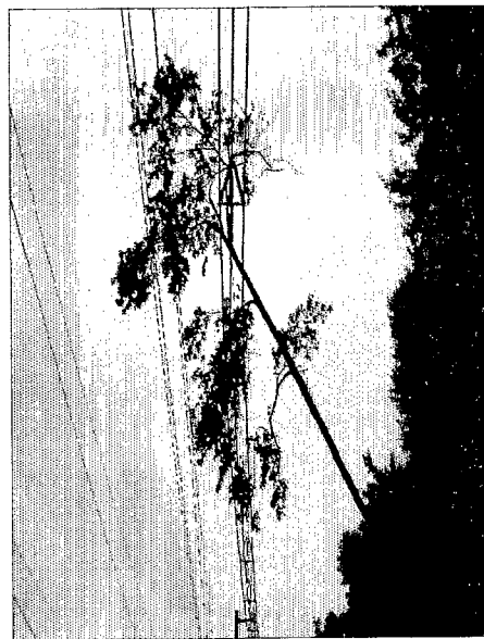
شکل (۱-۲) - شبکه کابل فاصله دار در عبور از مناطق پر درخت و جنگل
