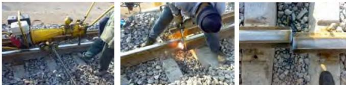
شکل (۲-۱۸) - مراحل جوش ترمیت از چپ به راست، باز کردن پیچ ها، برش قسمت معیوب و دو سر ریل بریده
