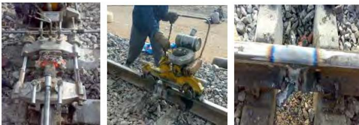
شکل ( ۲ - ۲۱) - مراحل جوش ترمیت از چپ به راست، کنار زدن مواد اضافی با فک ، سنگ زنی محل جوش و
