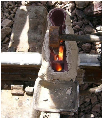
شکل (۲-۱۶) - عملیات پیش گرم کردن دو انتهای ریل ها [۲]
