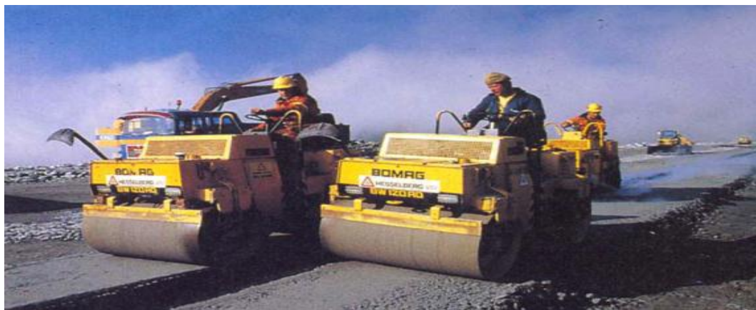
شکل (۱-۳): کوبیدن لایه های آسفالت و فیلتر مجاور آن بطور همزمان توسط غلطک های ارتعاشی
