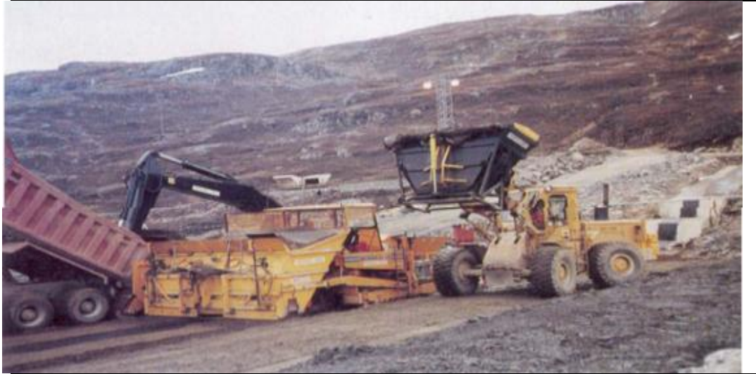
شکل (۴-۱): بارگیری مصالح آسفالت و فیلتر به دستگاه پخش کننده آسفالت
