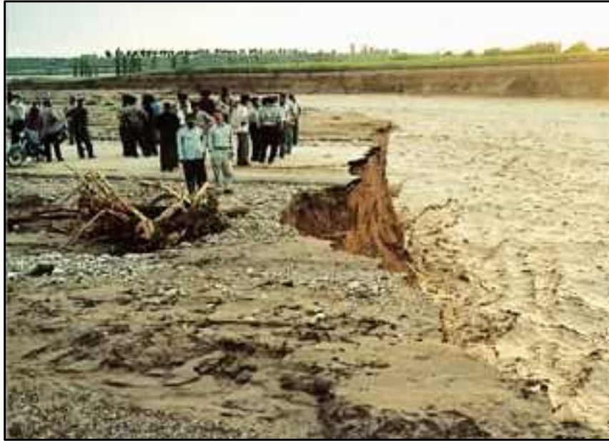
شکل ۱-۲. تخریب قسمتی از جاده و آب شستگی زمین های کشاورزی در اثر سیلاب [۲].
