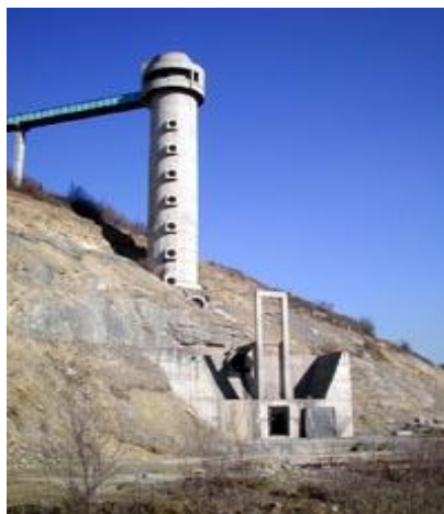
شکل ۱-۱- نمونه ای از برج آبیگر خود ایستا و پل دسترسی آن [۱].
