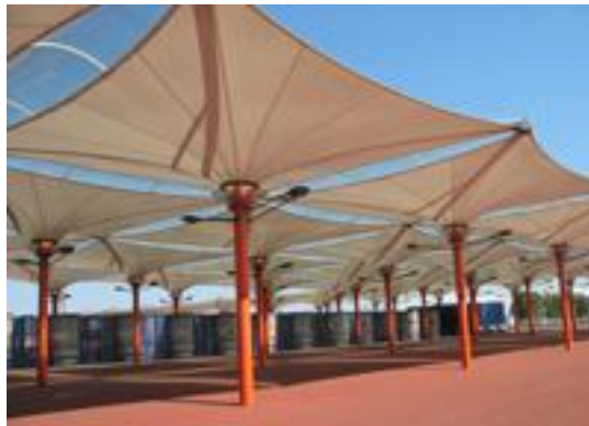
شکل 1-1: سازه تاشو با مکانیزم چتری
