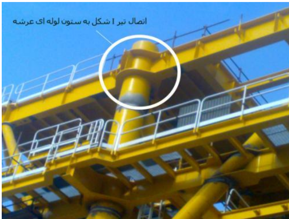
شکل ۳-۱ نمایشی از کاربرد وسیع اتصالات تیر I شکل به ستون لوله‌ای در سکوهای فراساحل
