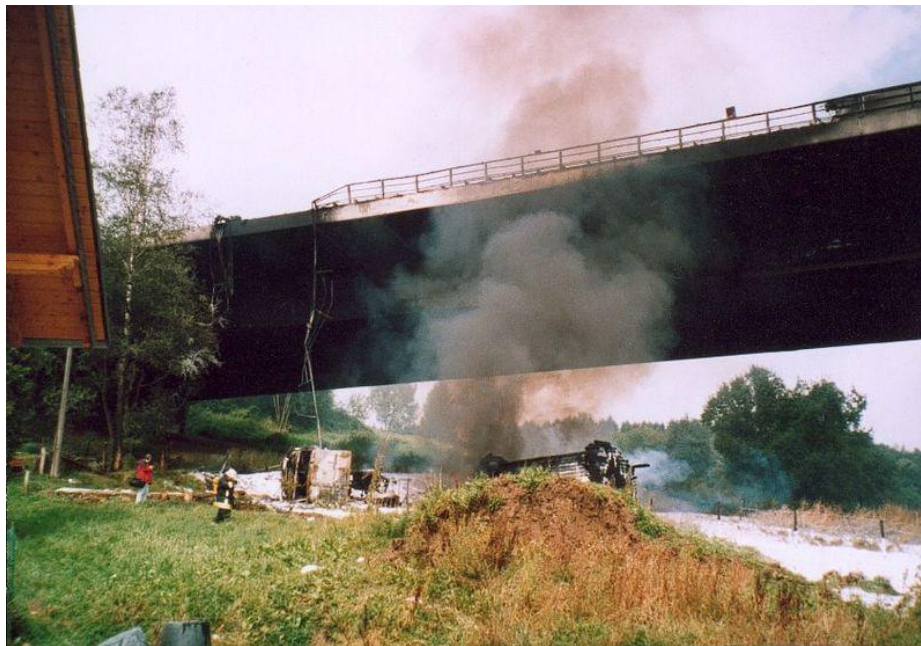
شکل ۳-۱ سقوط تانکر از پل در اثر برخورد با یک وسیله ی نقلیه ی دیگر و انفجار ۳۲ هزار لیتر مایع سوختی، هزینه ای بالغ بر ۲۸۰ میلیون یورو برای دولت آلمان در پی داشت [۴].
