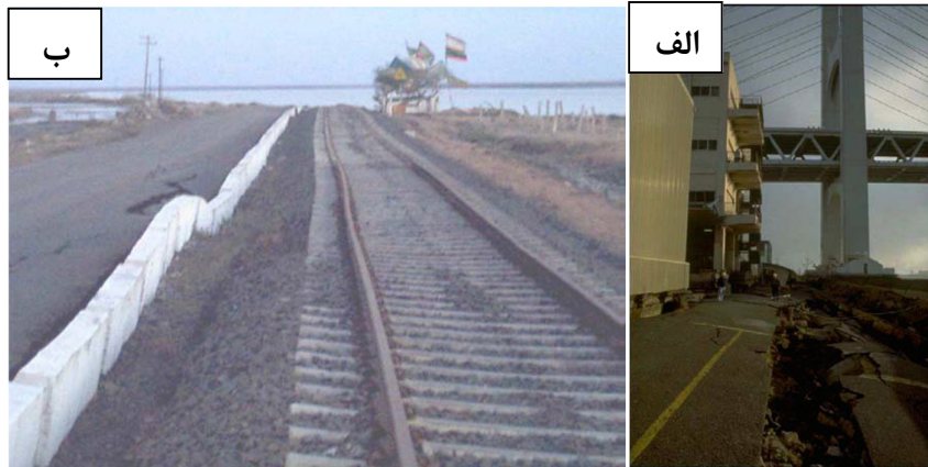
شکل ۴-۱: (الف) پدیده گسترش جانبی در اطراف پایه پل در زلزله کوبه (۱۹۹۵) (ب) پدیده گسترش جانبی در زلزله بیوج (۲۰۰۱)
