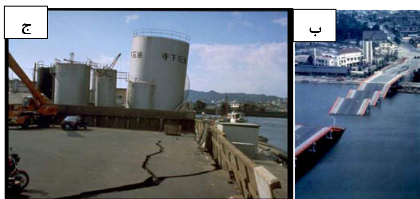
شکل ۲-۱: (الف) پلی در ایالات متحده بعد از زلزله آلاسکا (۱۹۶۴) - (ب) پل شوا ۱ در ژاپن بعد از زلزله نیگاتا (۱۹۶۴) - (ج) مخازنی در ژاپن بعد از زلزله کوبه (۱۹۹۵)
