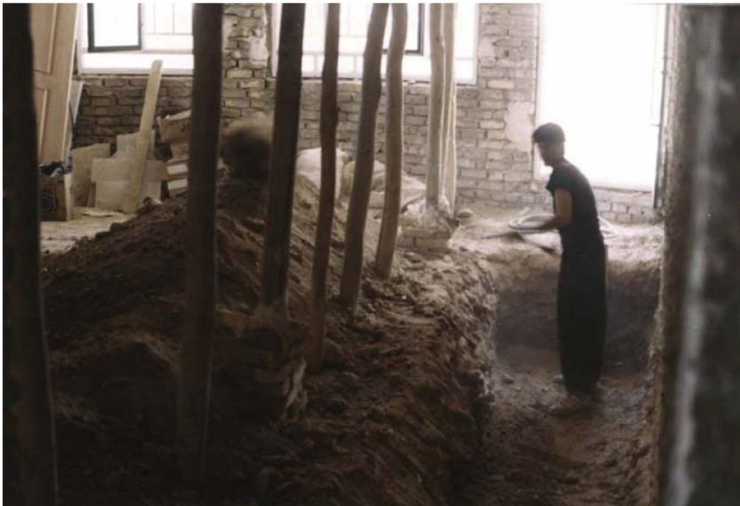
شکل ۲-۳- اجرای عملیات پی کنی به منظور اجرای فونداسیون خورجینی [۴]
