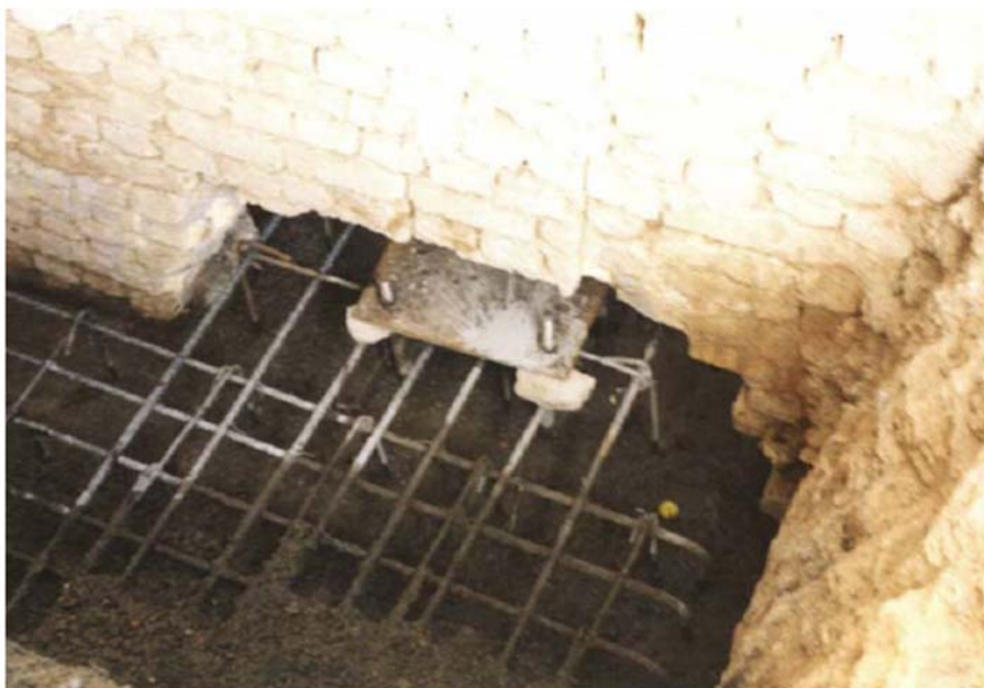
شکل ۲-۵- نحوه اجرای میلگرد گذاری و قرار گیری صفحه ستون در فونداسیون خورجینی [۴]
