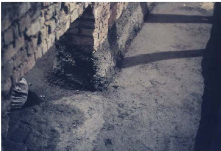
شکل ۲-۴- نحوه اجرای بتن مگر و تخریب دیوار در محل‌های تعیین شده به منظور اجرای ستون [۴]
