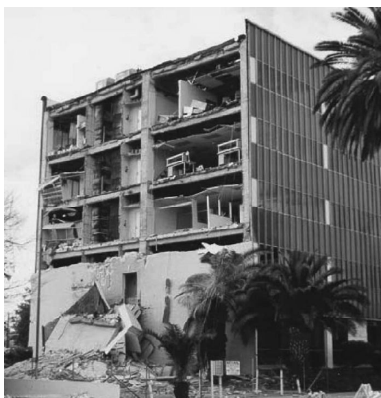
شکل 1-3: ریزش دیوار در حالی که اسکلت سازه هنوز سالم و قادر به تحمل بار است. نورسریج - کالیفرنیا 1994 [23].
