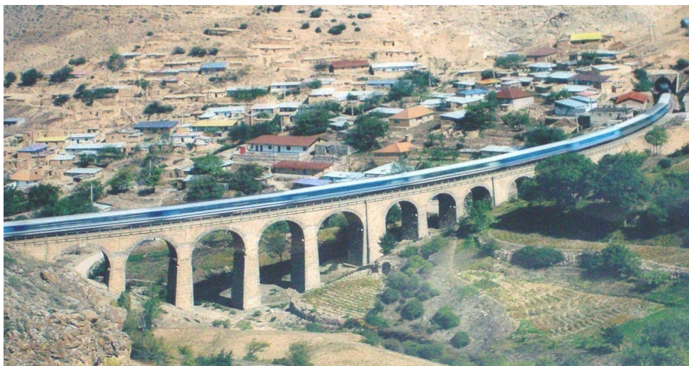
شکل ۲-۱۷ یکی از پلهای موجود در سیستم ریلی کشور
