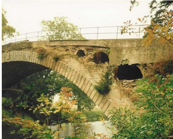
شکل ۲-۳ فضاهای خالی داخل پل برای سبک کردن سازه
