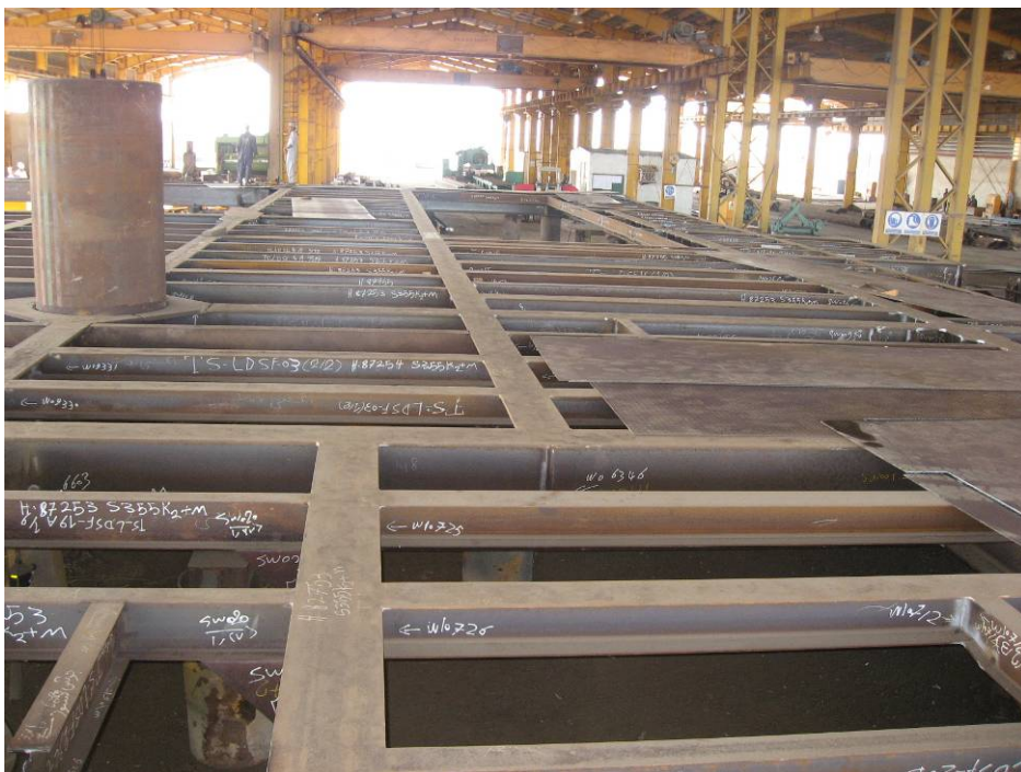
شکل (۱-۲): یکی از طبقات روسازه دریایی در حال ساخت با استفاده از مقاطع H شکل و I شکل
