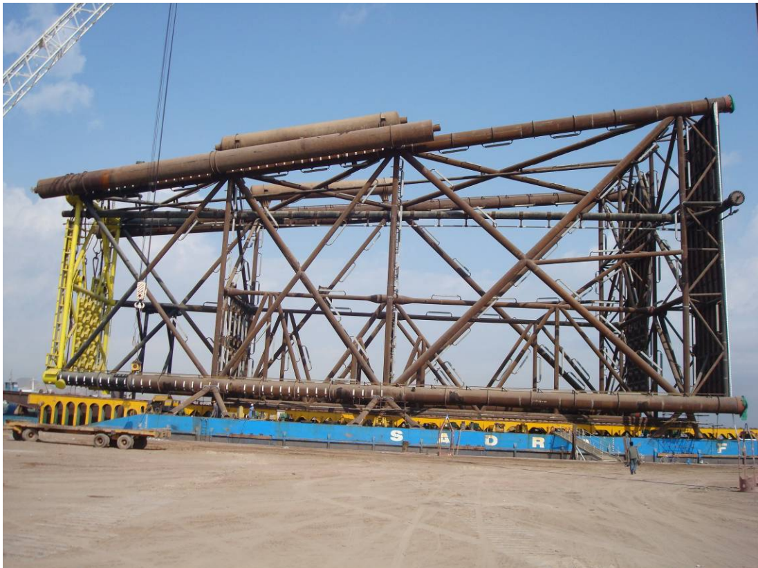
شکل (۱-۱): پایه سکوی ثابت دریایی ساخته شده از اعضا با مقاطع دایره‌ای
