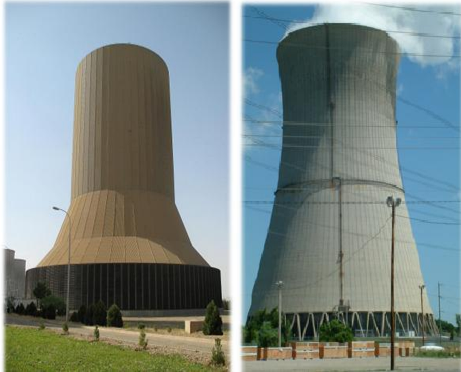
شکل ۱-۱: نمای برج خنک‌کننده‌ی بتنی (راست) و فلزی (چپ) [۱۴]
