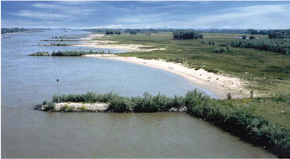
شکل ۱-۳ آبشکن‌های احداث شده در رودخانه‌ی راین آلمان به منظور تسهیل کشتیرانی [۲]
