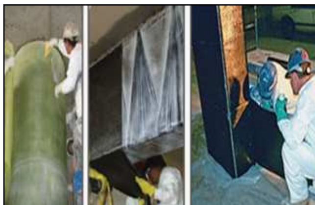
شکل ۱-۴-۱- اجرای صفحات پیش ساخته‌ی FRP [۱۰]
