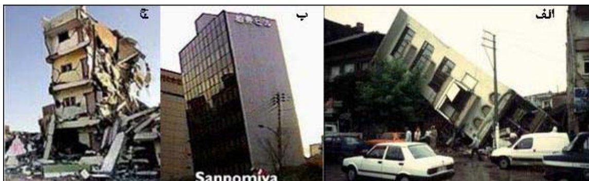
شکل ۱-۱ الف : واژگونی یک ساختمان در زلزله سال ۱۹۹۹ در کوسلی ترکیه ، ب: خرابی یک ساختمان بلند در زلزله کوبه ، ج: خرابی یک ساختمان مسکونی در طی زلزله سال ۲۰۰۱ هند [۲]
