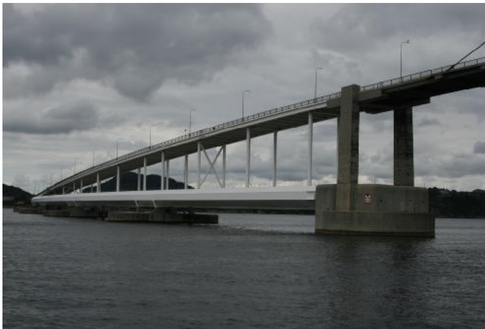
شکل ۲-۱ نمونه یک پل شناور با استفاده از پایه های بتونی و به کمک بارج های شناور [Internet]
