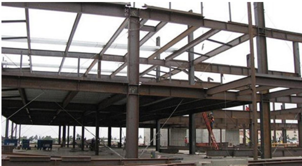
شکل ۱-۱: قاب خمشی فولادی
