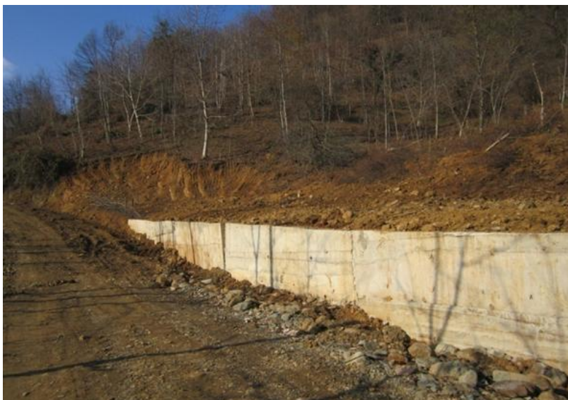
شکل ۱-۳: استفاده از سازه های مکانیکی در صورت لزوم برای حفظ شیروانی ها
