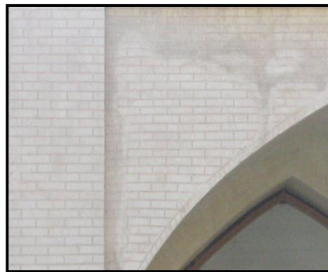
شکل ۱-۴- تزئینات گچی شبیه آجر - خانه داوید
