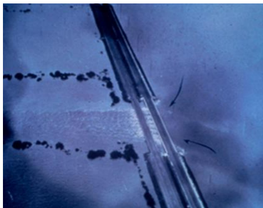
شکل (۲-۲) - انقباض جریان و افزایش سرعت در مقطع با احداث پل [۱۶]
