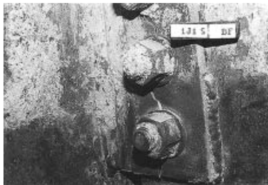
ث) شکست عمودی ورق اتصال جان تیر به بال ستون
