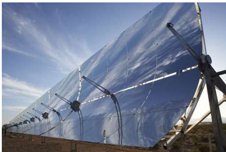
شکل ۱-۴: نیروگاه تولید برق خورشیدی [۳]
