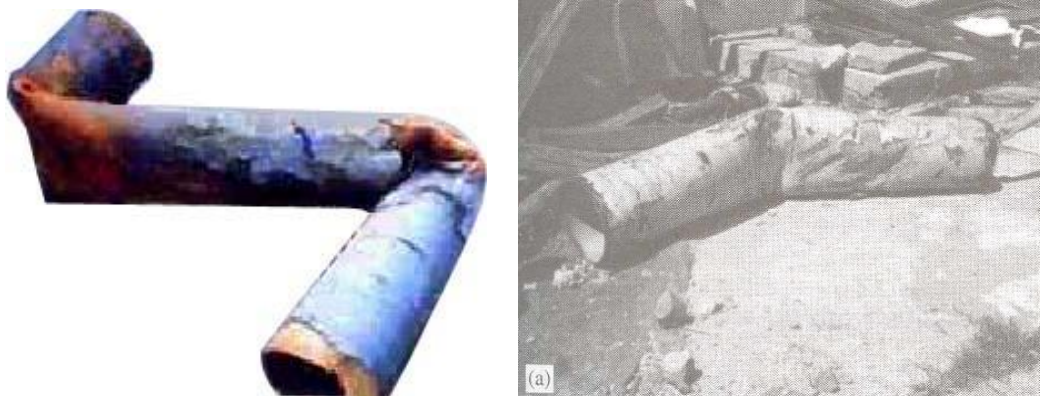
شکل ۴-۱ خسارات وارد بر لوله‌های مدفون در زلزله‌ی Kocaeli (ترکیه ۱۹۹۹) [۵]
