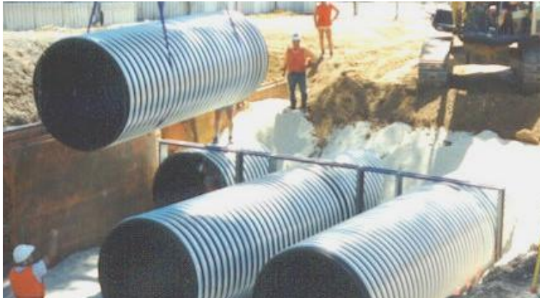
شکل ۶-۱ جانمایی لوله‌های پلی‌اتیلن با پروفیل موجدار دوجداره به منظور جمع‌آوری آبهای سطحی [۷]
