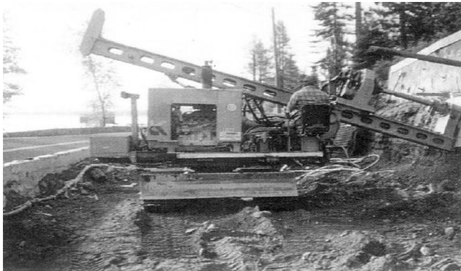
شکل ۲-۲- عملیات حفاری قبل از نصب میخ (Porter Field et al., 1994)
